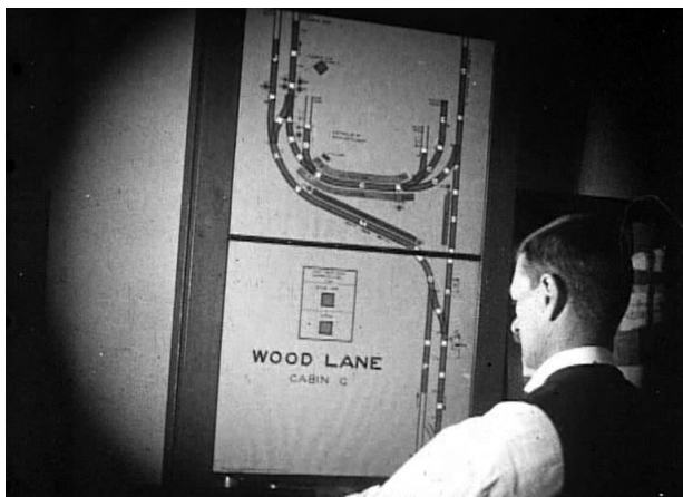
ABB. 7.6: Illuminated diagram zur Lokalisierung von Zügen. Digitaler Filmstill aus SIGNALLING ON THE EALING AND SHEPHERD'S BUSH RAILWAY , 1921 [2007].
