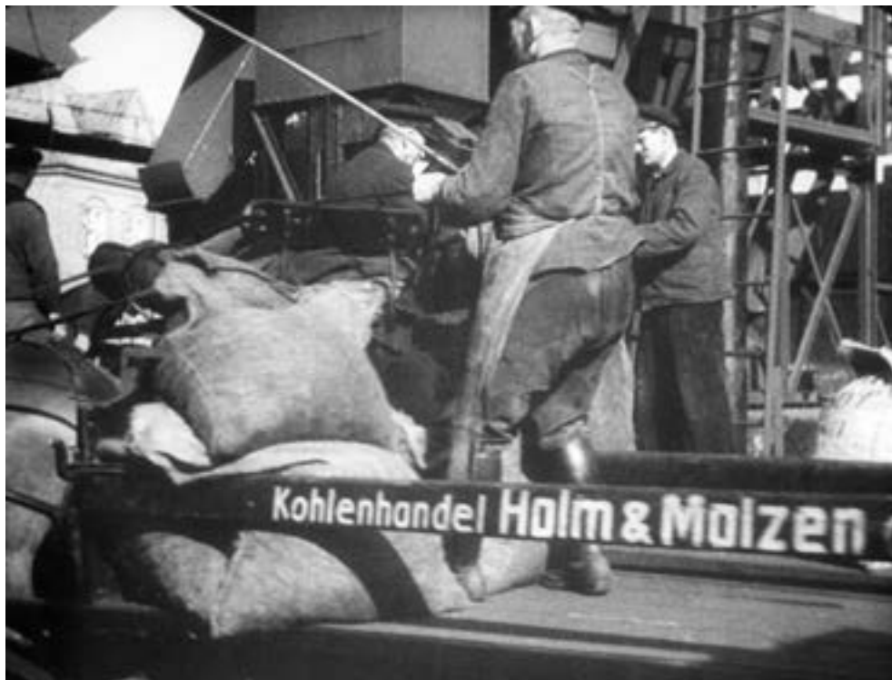
Die verschiedenen Arbeitsschritte im Kohlenhandel zeigt der Werbekurzfilm KOHLENHANDEL HOLM & MOLZEN, FLENSBURG (1937), wobei der Firmenname in einigen Einstellungen selbst ins Bild rückt
