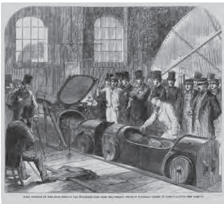
Abb. 1: Rohrpost aus dem Central Telegraph Office, London (1874)
