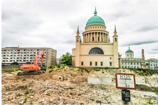
Abbildung 22: Als es 2019 drei historische Straßenverläufe auf dieser Fläche eines abgerissenen Gebäudes der Fachhochschule in Potsdams Mitte zu benennen galt, kam es zu öffentlichen Auseinandersetzungen. Foto der Baustelle aus dem Jahre 2020.
