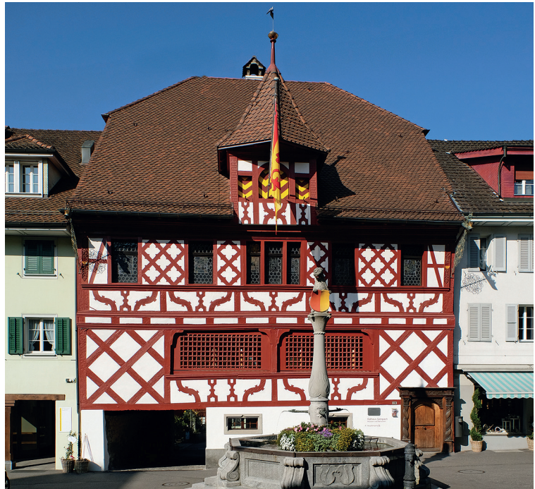
➔ 5 Das Rathaus Sempach – ein Fachwerkbau von 1475, der seit seiner umfassenden Restaurierung 2014 in neuem Glanz erstrahlt. (© Rathausmuseum Sempach. Foto: Otto Schmid)
