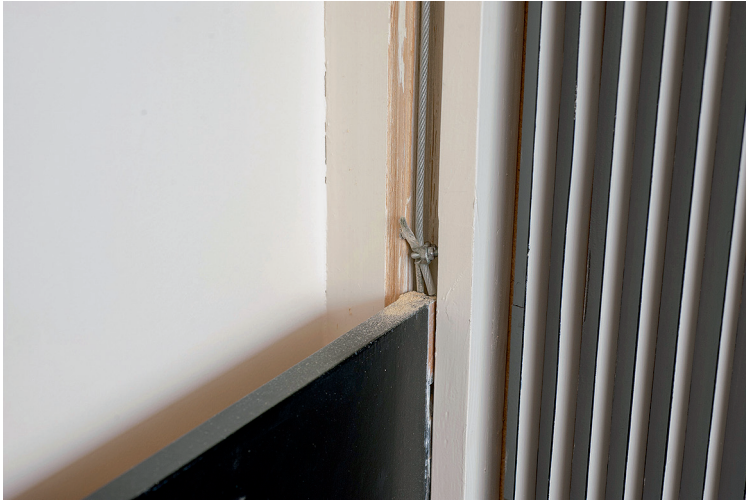
3 El Lissitzky, Kabinett der Abstrakten , 1927. Rekonstruktion von 1979 im Sprengel Museum Hannover. De- tail: Abnutzungsspuren an der Führungsschie- ne eines der vertikal zu verschiebenden Holzpaneele. (Foto: Herling & Gwose 2015. © Sprengel Museum Hannover)
