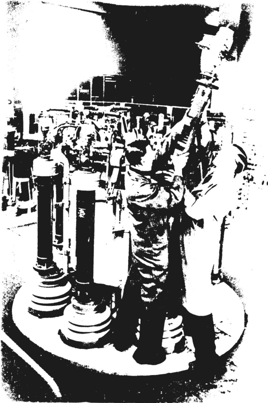
Auswechseln einer Röhre im zweiten 100-kW-Sender 1940. Telefunken-Werkaufnahme vor der Aufstellung des Senders in Hamburg
