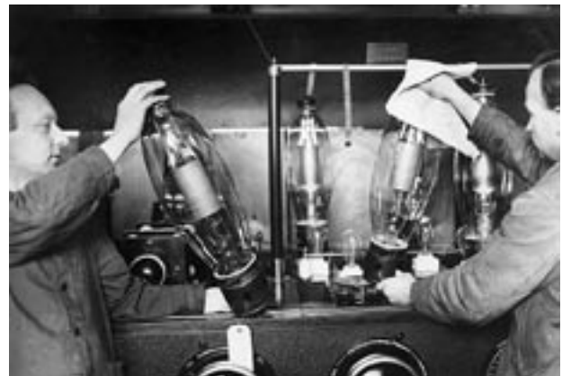
Wechsel einer RS 15 Sender-Endröhre beim Sender Leipzig anfang der 30er Jahre. Foto: Schröter / DRA
