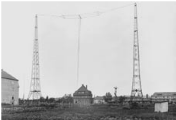
Sendergebäude und Antennenanlage des Nebensenders Stettin 1933. Foto: RRG / DRA
