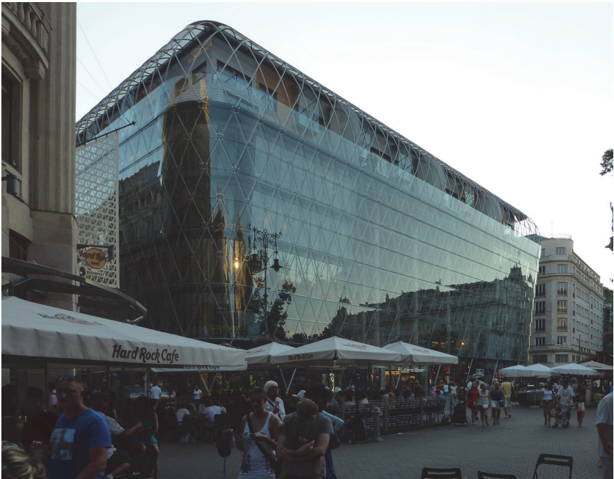
13 – Mehrzweckgebäude am Vörösmarty tér, Budapest, György Fazakas und Jean-Paul Viguier, 2002–2007. – Futuristische ‚smartphone architecture‘ in einer traditionellen städtebaulichen Umgebung.
