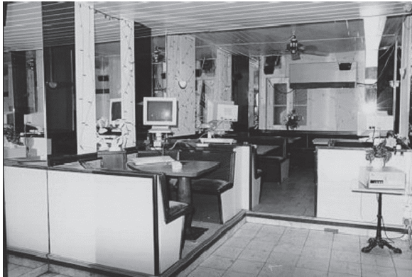
2 – Die Platzierung von Röhrenbildschirmen wird zum sichtbaren Zeichen einer Umnutzung bestehender gastronomischer Einrichtungen, wie hier in München.
