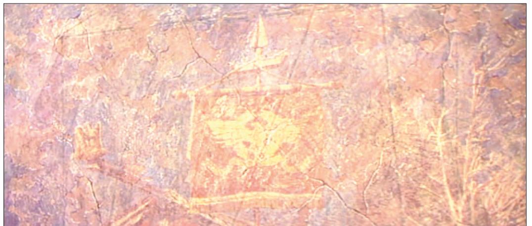
Abb. 3.16 – Beschädigtes Fresko, CLEOPATRA
