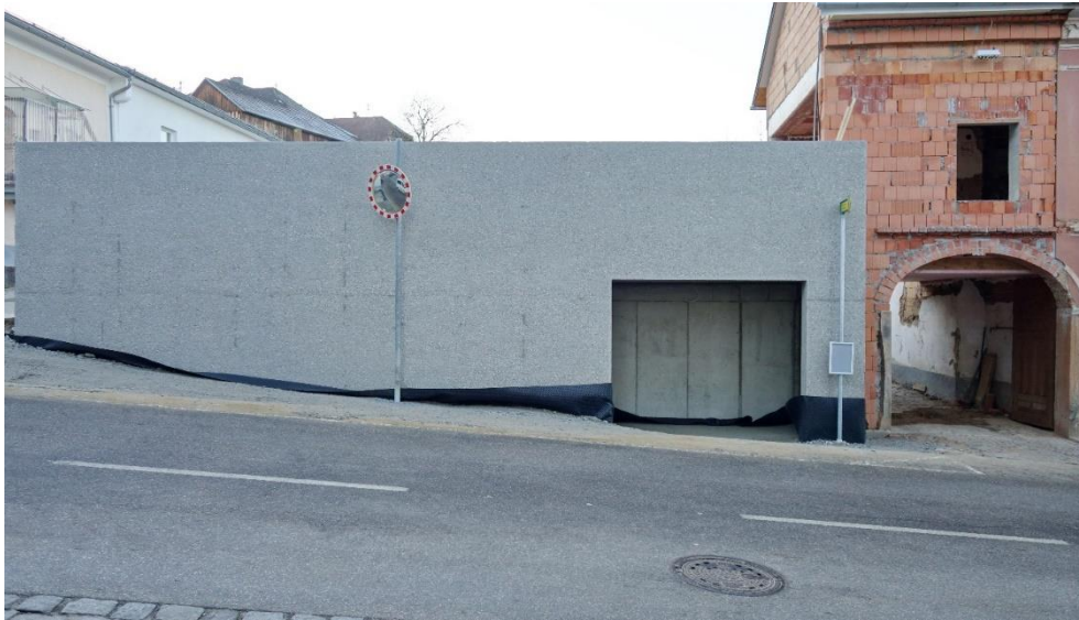
Abb. 1: Geburtsaus des Gelehrten Adam von Lebenwaldt aus dem 16. Jahrhundert mit Blindportal und wieder instandgesetztem Kollateralschaden am barocken Nebenhaus, 2019.
