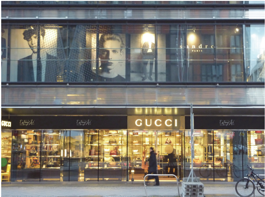
15 – Galeries Lafayette, Berlin Friedrichstraße, Jean Nouvel, Emmanuel Cattani & Associés, 1991–1996. – Die traditionelle ausgearbeitete Fassade wurde hier durch eine Art Glasdisplay ersetzt, das abwechselnd Gesamtansichten des Gebäudeinnern, geschosshohe Werbung und zufällige Spiegelungen der Umgebung bereithält.
