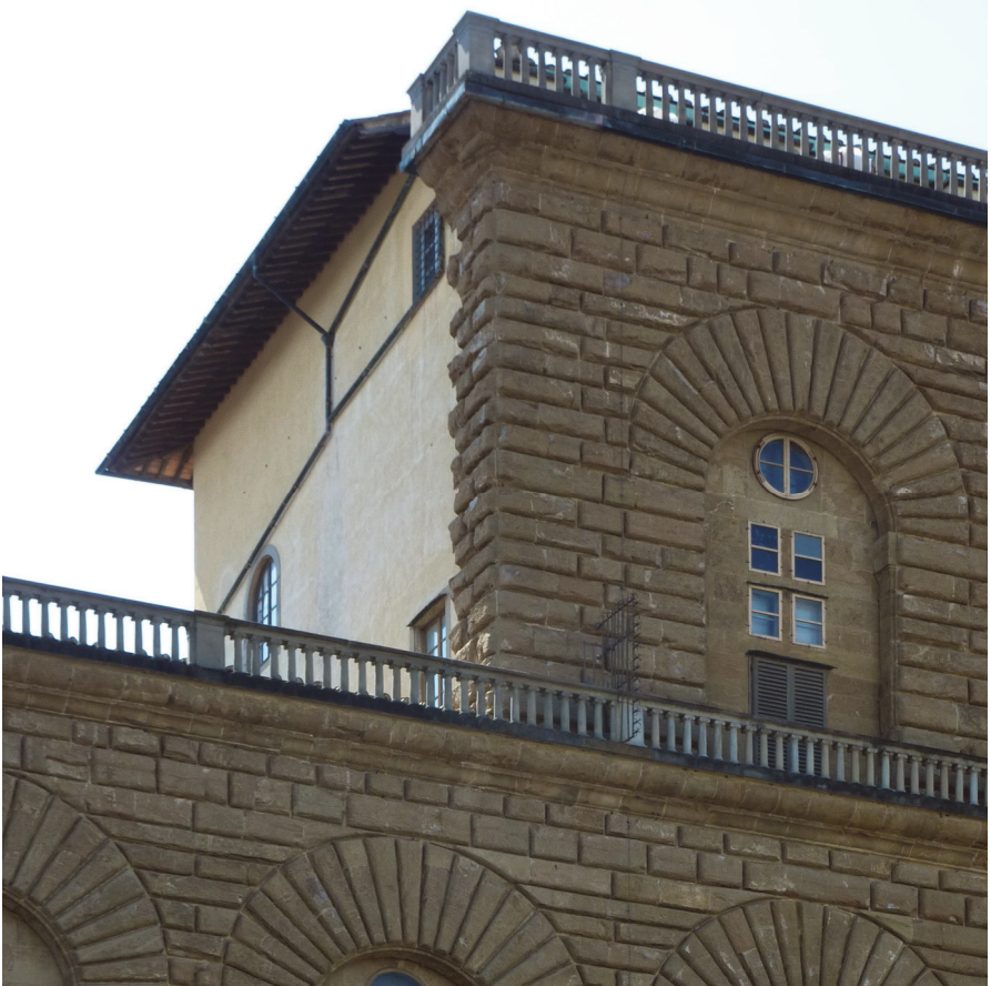
1 – Unterscheidung von Außenwand und Fassade am Beispiel des Palazzo Pitti, Florenz, Ursprungsbau wohl von Luca Fancelli, 1458–1466; die hier in einem Eckdetail abgebildete Erweiterung des Hauptbaus aus der ersten Hälfte des 17. Jahrhunderts. Die Fassade bringt unter anderem Machtanspruch und Wehrhaftigkeit zum Ausdruck.
