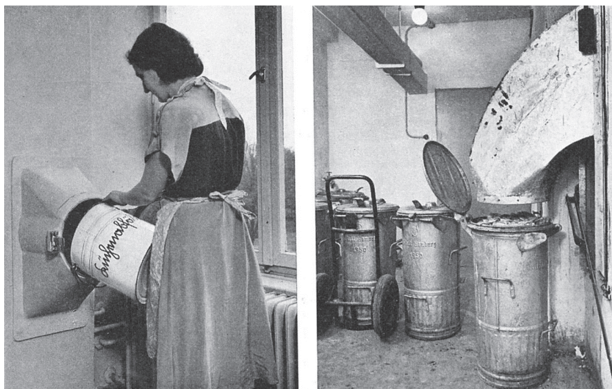
7 – Müllabwurfschacht in Hamburg (1955)
